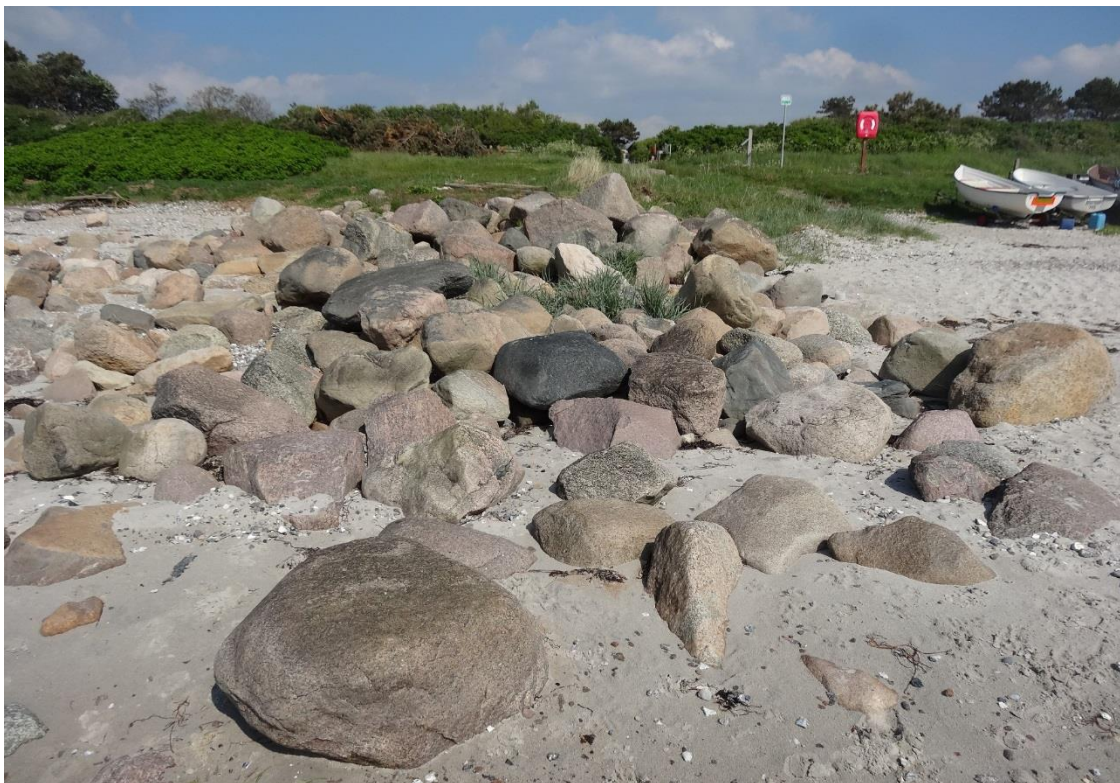
Stenkastning ud for nedgangen ved campingpladsen i den sydligste ende af den besigtigede strækning.
